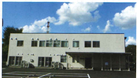
仮設福祉園の外観
