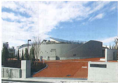
←外観・東面の全景
