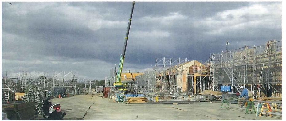
骨組みが出来つつある工事現場
