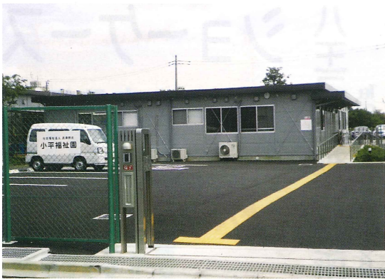
仮施設の正面・管理棟
